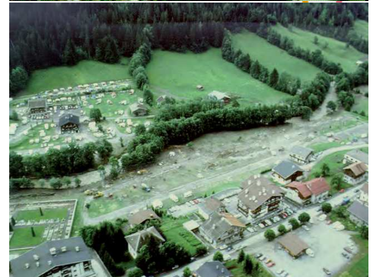
Le pont de Suize situé sur le Chinailon ; Le camping du Grand-Bornand le 14/07/1987
